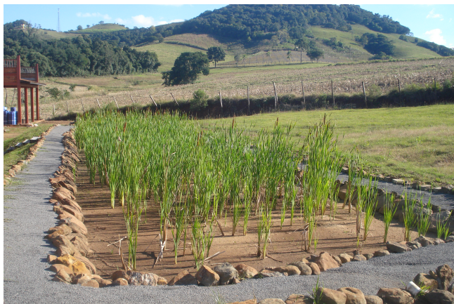
Figura 1 - Vista sistema de tratamento por wetland construído , sistema subsuperficial, com plantas em desenvolvimento.
