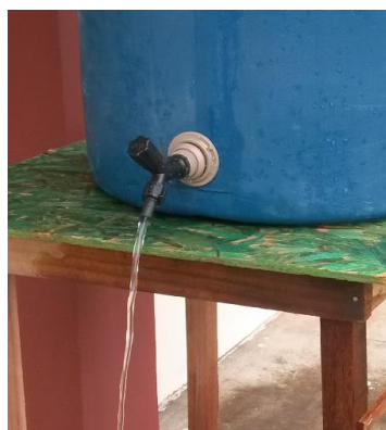
Figura 2 - Torneira para aproveitamento da água armazenada.
