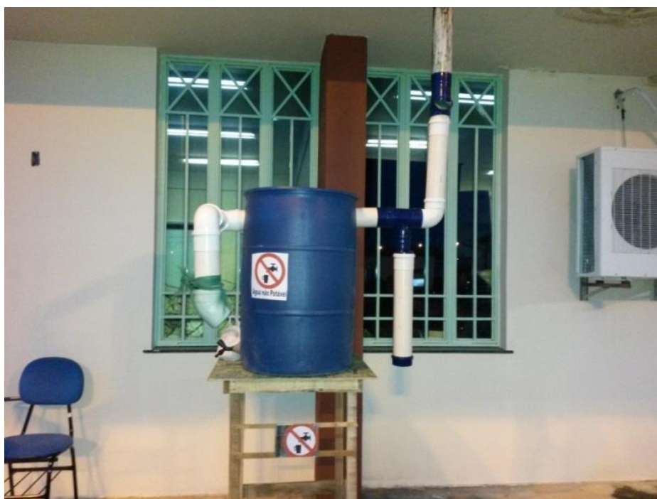
Figura 4 - Sistema de captação e armazenamento de água da chuva.
