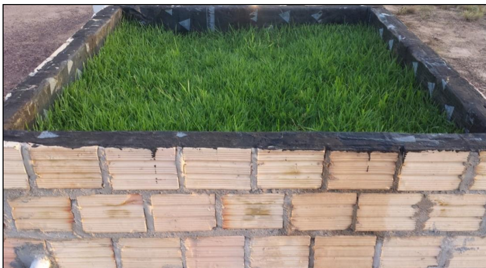
Figura 5 - Telhado verde após 15 dias de implantação da cobertura.
