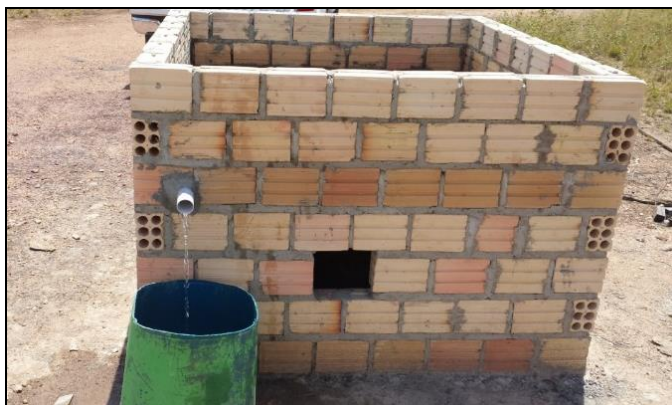
Figura 3 - Estrutura base do protótipo de telhado verde.
