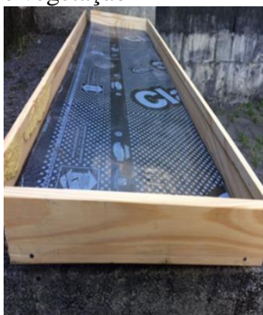
Figura 1 – Fases de implantação do telhado verde: a) geomembrana; b) geotêxtil; c) argila e d) substrato e vegetação
