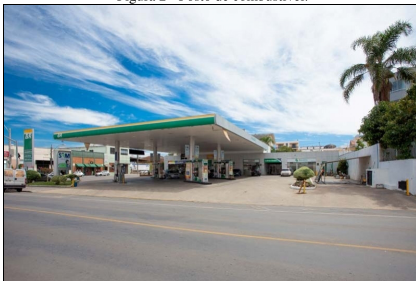
Figura 2 - Posto de combustível.
