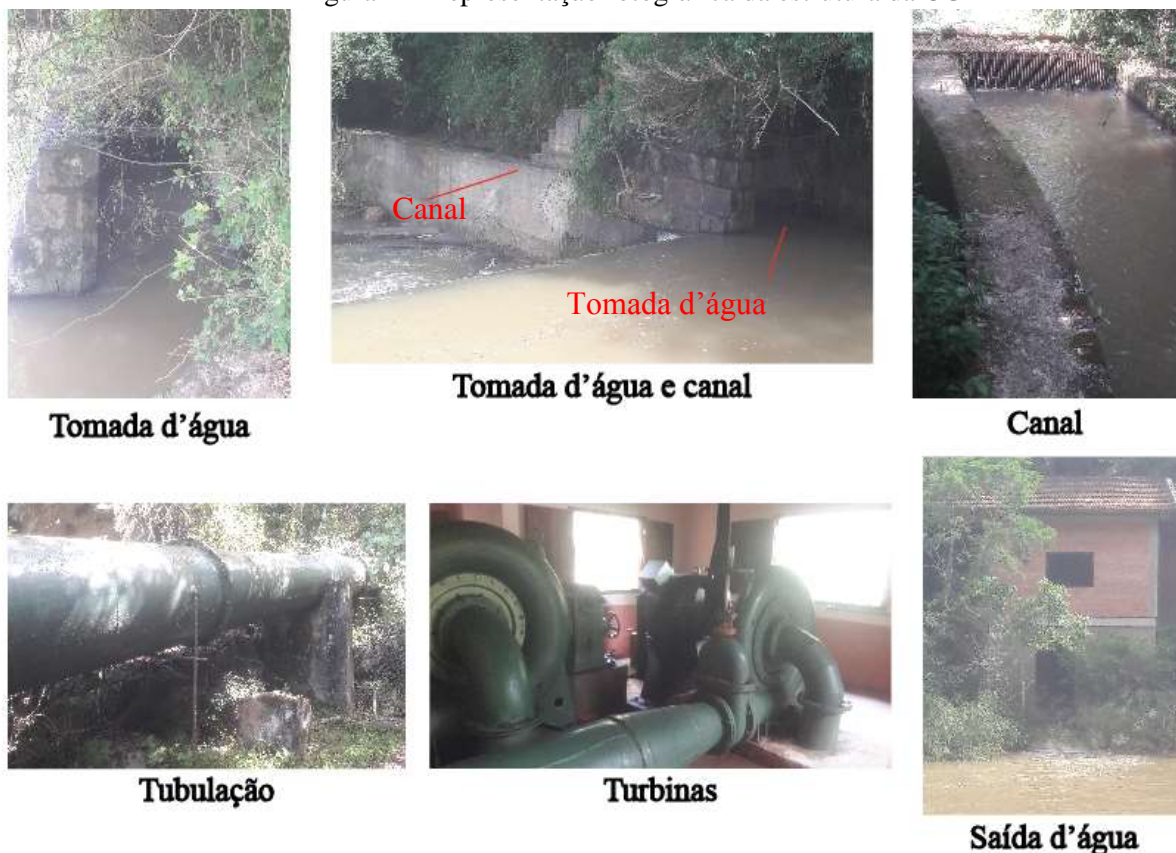
Figura 1 – Representação fotográfica da estrutura da CGH
