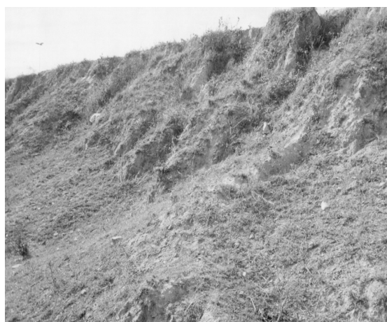
Figuras 5 e 6 – Processos erosivos ativos (sulcos e voçorocas) comprometendo a infra-estrutura ao longo de todo o açude. Coordenadas: 7°12'51,7"S e 35°54'39,7"W (Foto de 07.2007)
