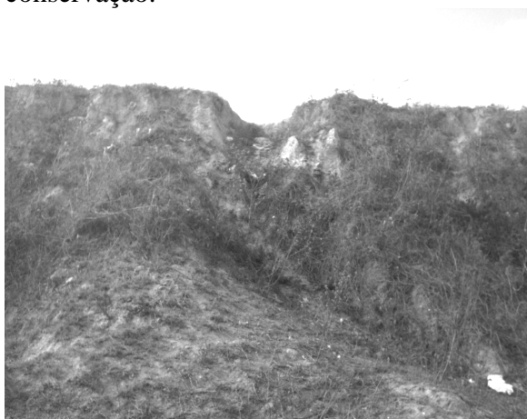
Figuras 5 e 6 – Processos erosivos ativos (sulcos e voçorocas) comprometendo a infra-estrutura ao longo de todo o açude. Coordenadas: 7°12'51,7"S e 35°54'39,7"W (Foto de 07.2007)
