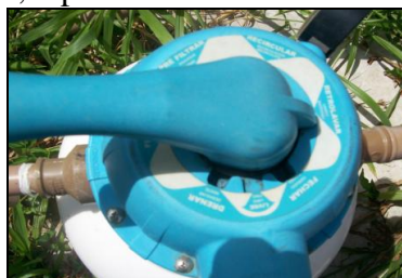
Figura 2 - Filtro na posição de retro lavagem
