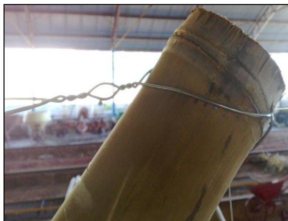
Figura 6- Detalhe mostrando como tensionar ao entrelaçar os arames das extremidades.
