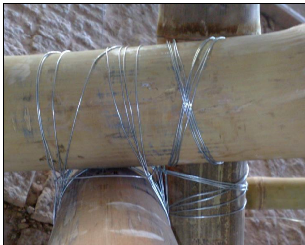
Figura 8 Fixação central executada com arame nº 18.
