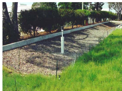
Figura 4 – Trincheira de Infiltração em área urbana. (Fonte: California Stormwater BMP Handbook, New Development and Redevelopment (2003).
