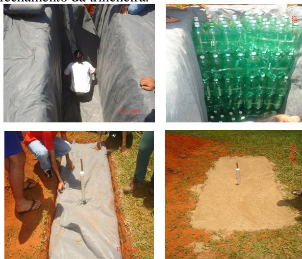
Figura 6 – Montagem da célula in situ na UnB.
