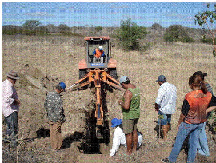
Fonte: FERNANDES NETO, Silvana (2007) – dia de campo Figura 04: Construção da vala transversal ao leito do riacho.
