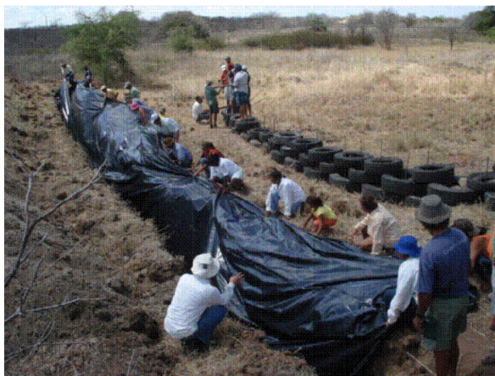
Fonte: FERNANDES NETO, Silvana (2007) – dia de campo Figura 05: Colocação da lona plástica no interior da vala.
