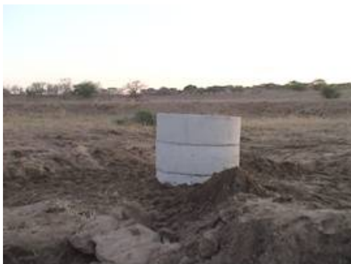
Figura 07: Anéis de concreto constituindo o Poço Amazonas.
