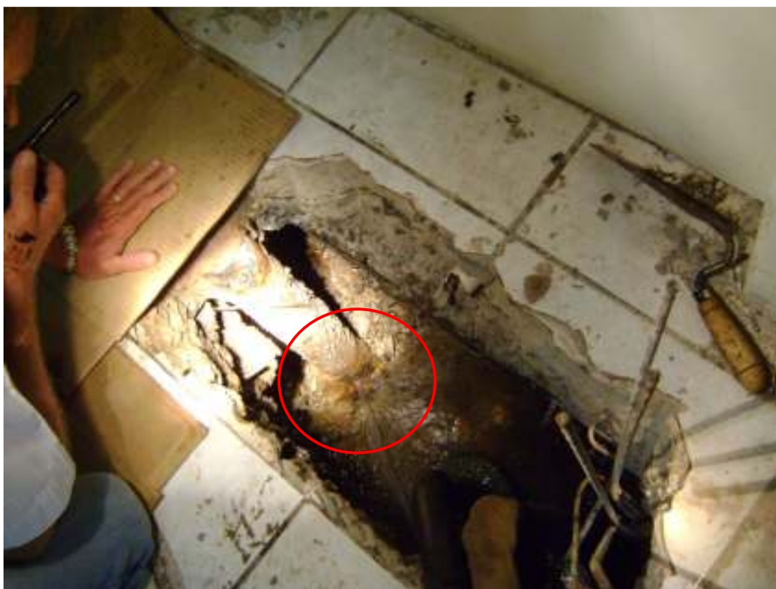
Figura 06 - comprovação de vazamento descoberto com auxílio da telemedição num grande cliente.
