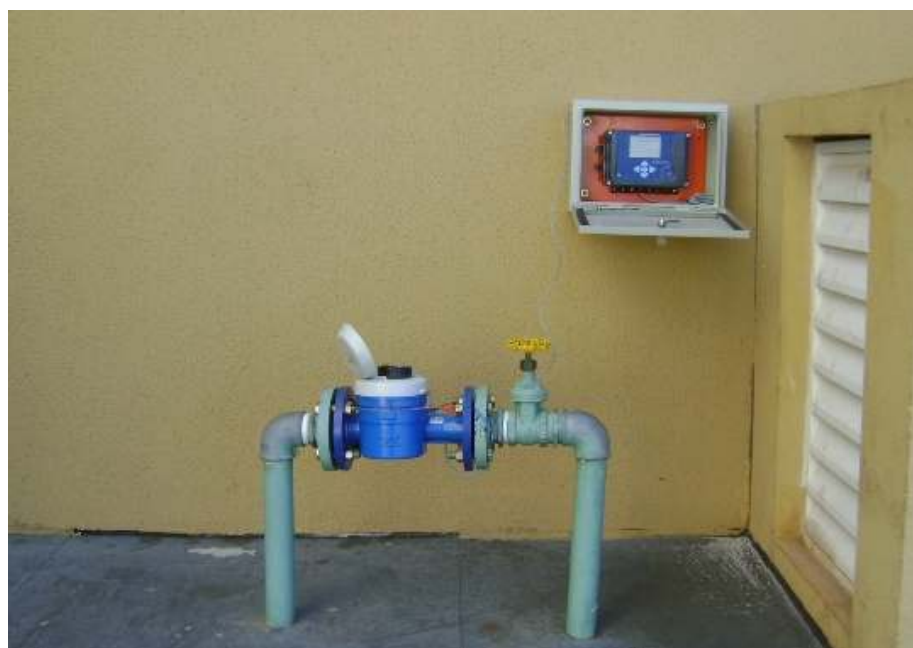
Figura 02 - montagem do sistema em campo: hidrômetro, sensor e transmissor de dados.
