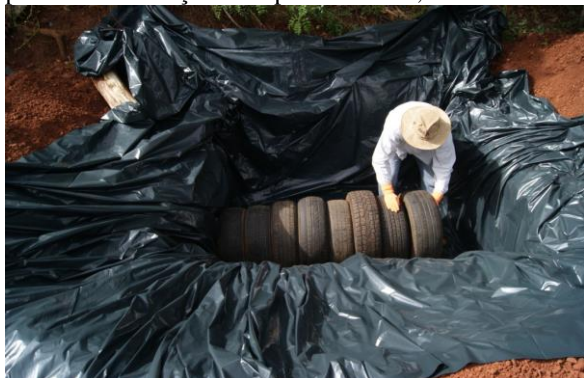
Figura 2 – Escavação, impermeabilização com lona plástica e tubulação com pneus usados;
