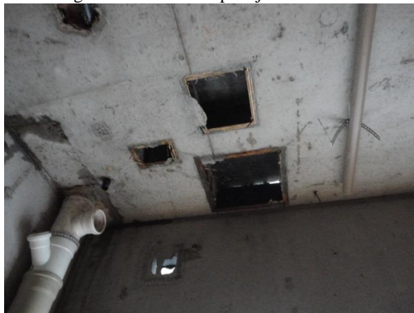
Figura 4. Caixas de espera já concretadas.
