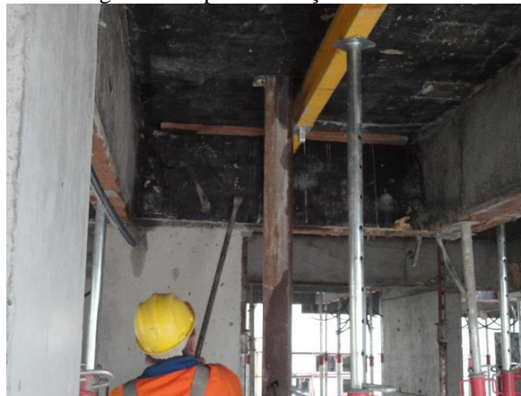
Figura 2. Etapa de remoção das formas.
