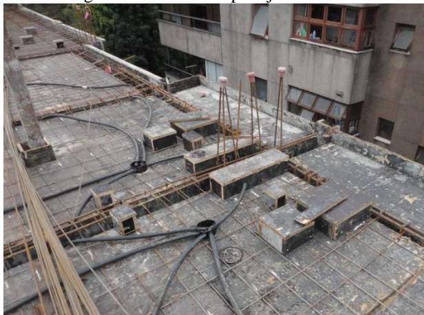
Figura 3. Caixas de espera já instaladas.
