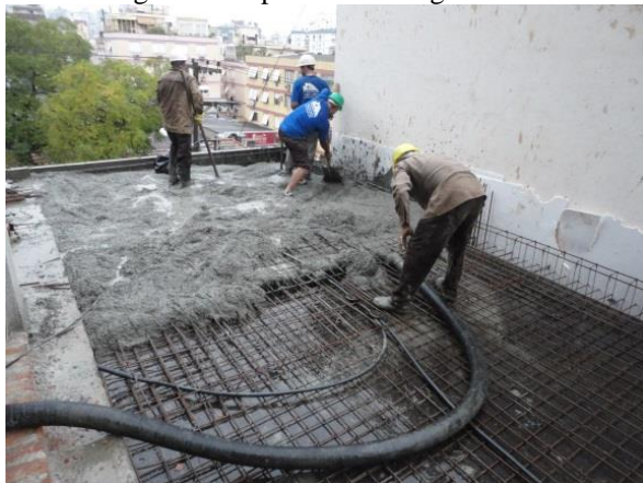
Figura 1. Etapa de concretagem.
