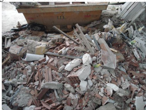
Figura 1 – Coleta de RCD na fase de alvenaria.
