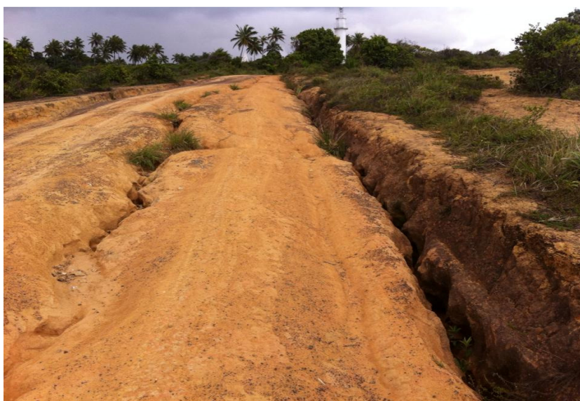
Figura 2 – Ravina na encosta central de uma via de acesso do Parque, desencadeada pela ação antrópica
