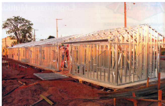
Figura 2 - Estrutura do telhado de residência LSF.
