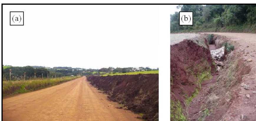
Figura 5 - (a) Ocupação da pista, estacas 30 a 38 (b) Despejo de entulhos, estacas 125 a 130.
