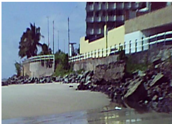
Figura 3 - Barreira de contenção para evitar deslizamento
