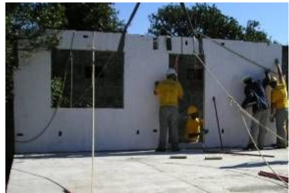
Figura 2: a - posicionamento da laje de piso sobre as fundações e b – içamento do painel de vedação.
