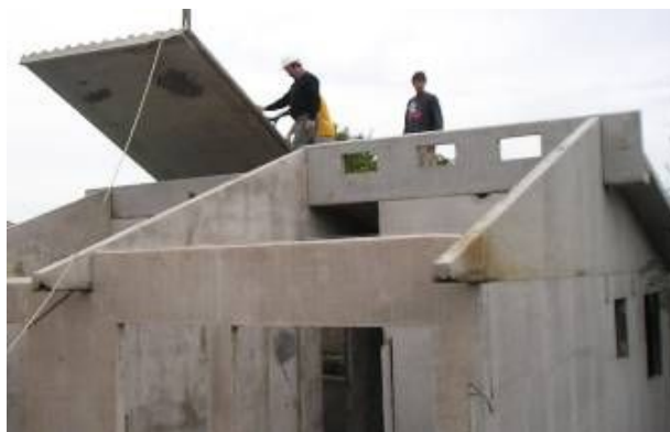
Figura 4: a – colocação do painel de cobertura e b - colocação do primeiro painel da parte frontal da cobertura
