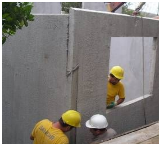
Figura 3: a – posicionamento do painel de vedação e b – encaixe dos painéis de vedação
