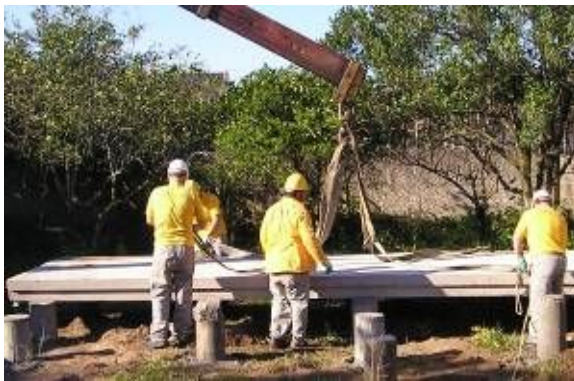
Figura 2: a - posicionamento da laje de piso sobre as fundações e b – içamento do painel de vedação.
