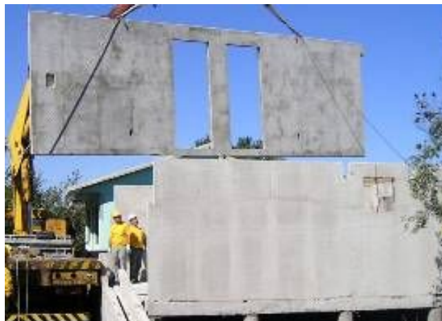
Figura 3: a – posicionamento do painel de vedação e b – encaixe dos painéis de vedação
