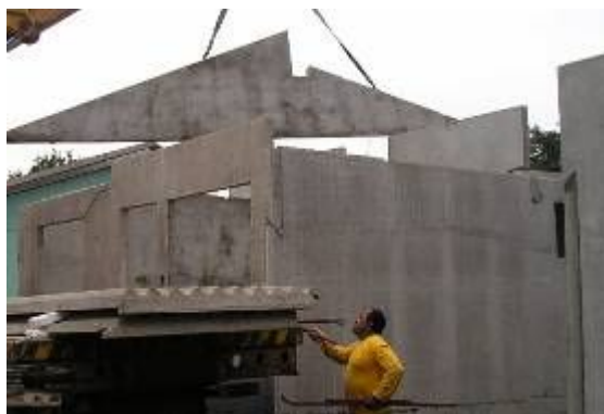
Figura 4: a – colocação do painel de cobertura e b - colocação do primeiro painel da parte frontal da cobertura
