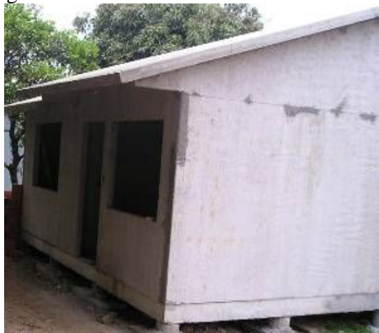
Figura 5: a - reparo de cantos e partes danificadas dos painéis após a montagem e b – pintura da habitação após colocação das esquadrias
