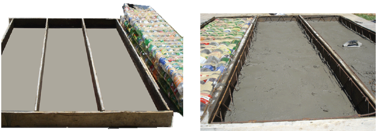
Figura 7: a – preparo dos moldes e encaixe das garrafas e b- argamassa de base com colocação de garrafas e armaduras.
