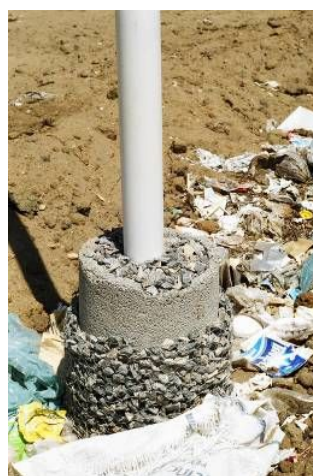
Figura 1 - a) Calhas de águas pluviais; b) Drenos de gases; c) Poço de monitoramento do percolado.
